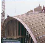
L'efficacité de l'isolation dans les murs creux est souvent limitée par une mauvaise jonction avec l'encadrement intérieur du mur et par les fentes entre les panneaux. Ici, l'isolation est parfaitement maintenue en place et rendue étanche au vent par le panneau de protection de l'isolation Celit 3D.
