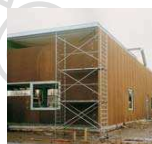
Habitations en penthouse: quatre appartements construits avec une ossature en bois, rapusés sur la terrasse de toit d'un immeuble à appartements existant.
