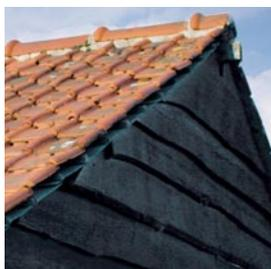
5. Le manque d'accessoires pour une finition technique et esthétique parfaite de la toiture constitue un autre point négatif des anciennes tuiles. Auparavant, on fixait les faitières et les arêtiers au mortier et on ne récupérait donc que très peu d'accessoires intacts lors de la destruction d'immeubles. Certains accessoires qui sont aujourd'hui indispensables, par exemple pour la ventilation de la sous-toiture, n'étaient même pas fabriqués par le passé.
